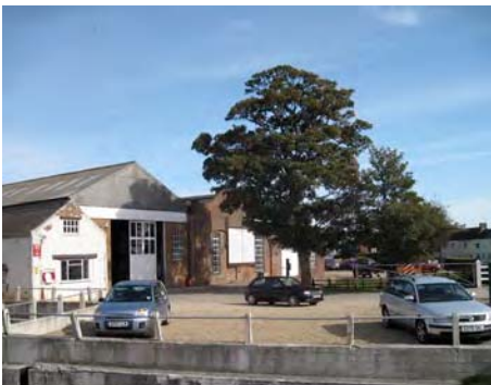
Welland & Deepings IDB Workshops, Pode Hole
